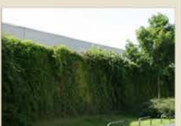
5. Ansicht der Lärmschutzwand nach 3-jähriger Bewässerung
