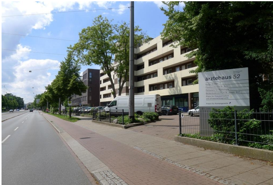
■ Östliche Einfahrt (Nr. 52)
