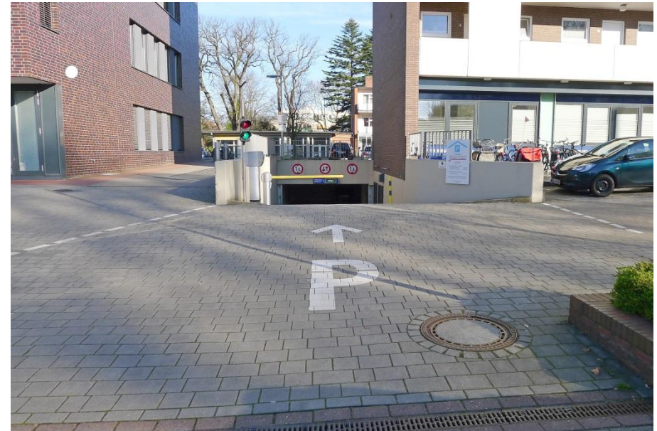
■ Tiefgarage Medicum mit einstreifiger Rampe
