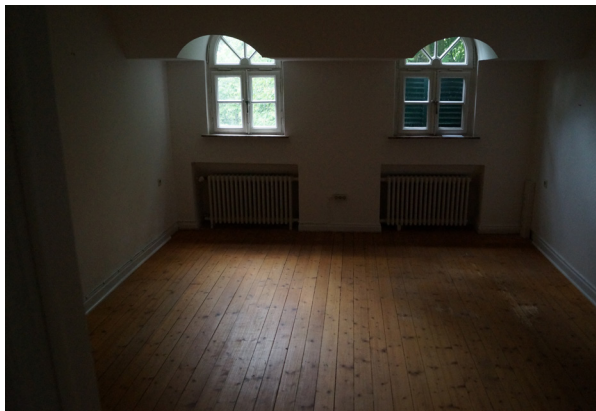
Räume als Lagerfläche im 2. Obergeschoss
