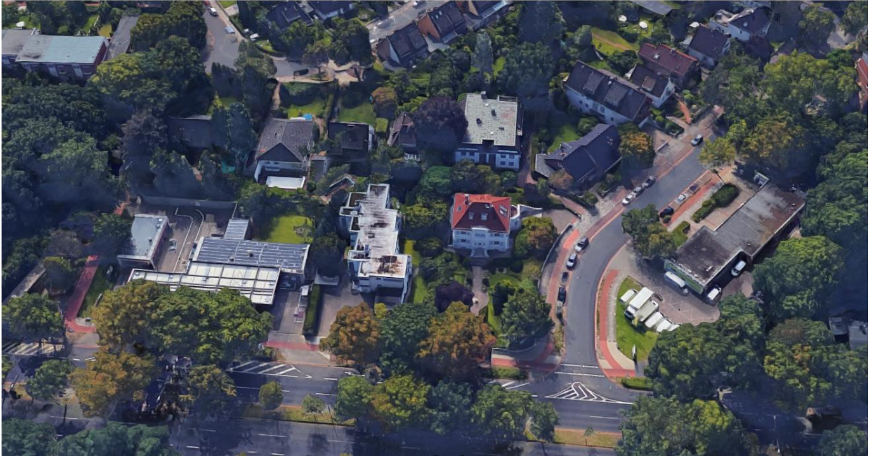
Luftbild Bestand / Blickrichtung Süden
