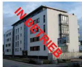
„Kaltes Nahwärmnetz Park De Roock“ Ingelheim Hier werden über ein kaltes Nahwärmnetz 10 RH und 4 Doppelhäuser sowie ein MFH über eine kaltes Nahwärmnetz versorgt. Wohnfläche ca. 28.000 m<sup>2</sup>
