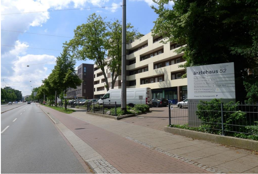
■ Östliche Einfahrt (Nr. 52)
