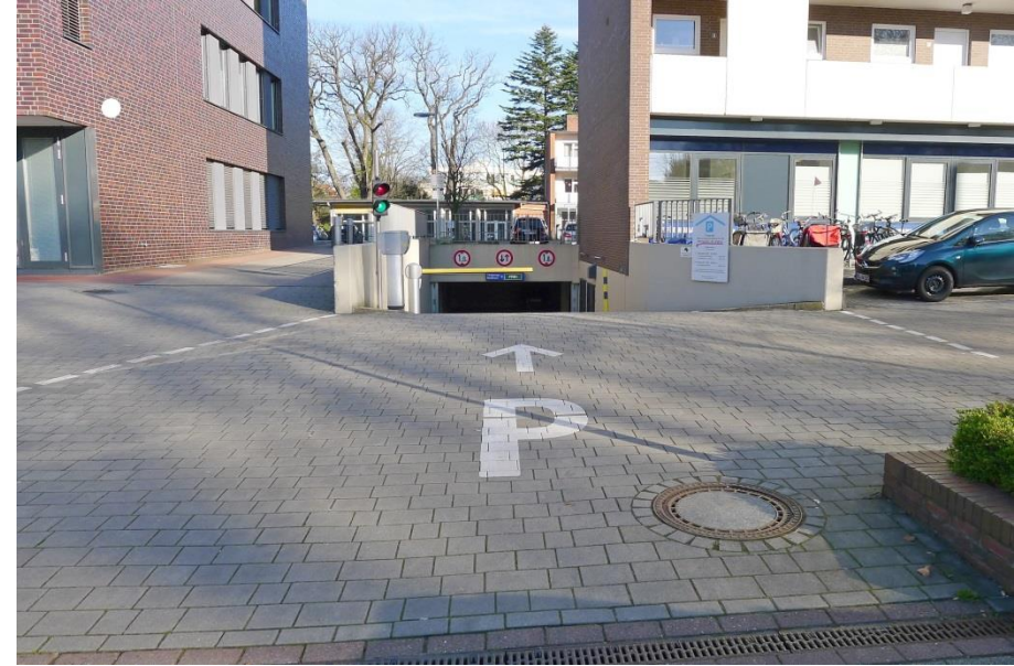
■ Tiefgarage Medicum mit einstreifiger Rampe
