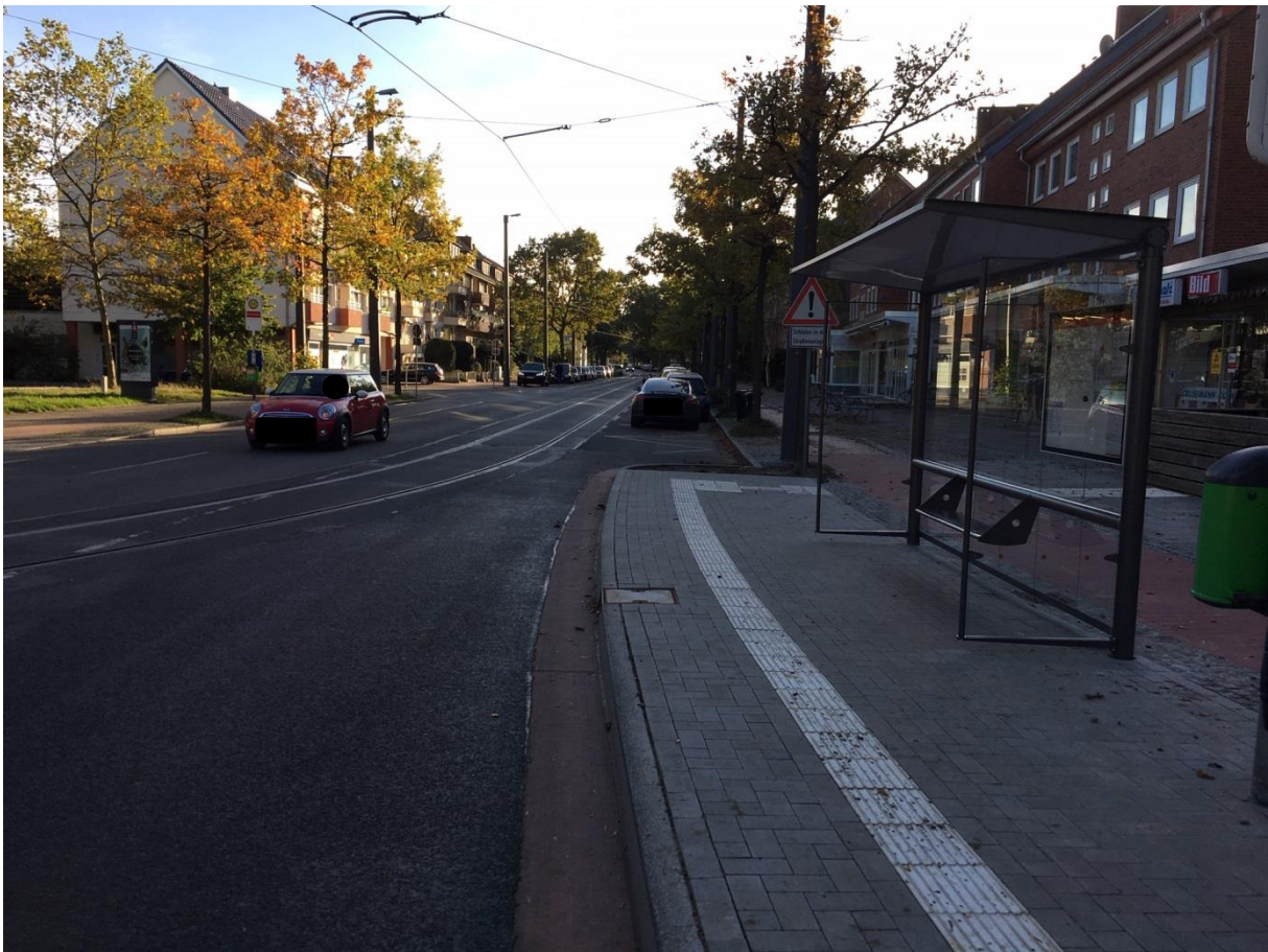
Sichtbereich in die Crüsemannallee mit der alten Haltebucht und jetzigen Wendebereich der verkürzten Linie 22
