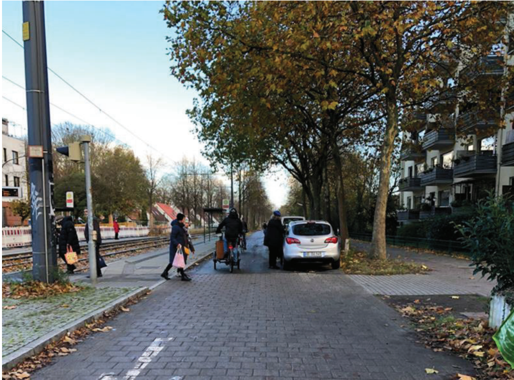
Foto 1: Durch parkende Kfz eingeschränkte Radpremiumroute in Verlängerung der H.-H.-Meier-Allee (südöstliche Fahrspur) zwischen Wätjenstraße und der Fußweganbindung zur Depkenstraße.
