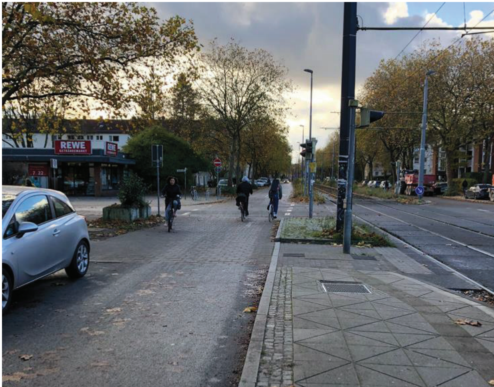
Foto 6: Die Fahrzeuge aus Richtung Universität sind gegenüber den Fahrzeugen der kreuzenden Fahrzeuge auf der Wätjenstraße (durch den baulich durchgezogenen Bord) wartepflichtig. Es fehlt das Schild „Vorfahrt gewähren“
